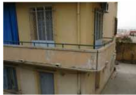
Figure 22 : Cité Brincat (2), « La Pinède », Poutres des passerelles et balustrades des balcons préfabriquées. Entreprise présumée :P-L.Giovanelli. Source : Photo de l'auteur 2016
