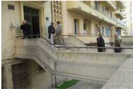
Figure 22 : Cité Brincat (2), « La Pinède », Poutres des passerelles et balustrades des balcons préfabriquées. Entreprise présumée :P-L.Giovanelli. Source : Photo de l'auteur 2016
