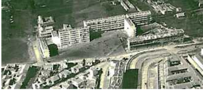
Figure 44: La cité du palmier (Diar Enakhla), Source: Source: PUD de Sétif, Dautreveau 1962. La prépondérance de l'orientation est et ouest en faveur des principes hygiénistes Le bâtiment de la cité des remparts en cours de construction
