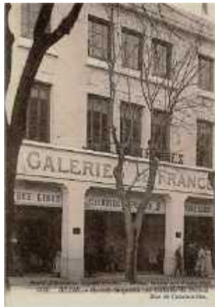
Figure 96 : Les galeries de France, une nouveauté dans la programmation urbaine Source : https://www.google.dz/Sétif/ Galerie de France .
