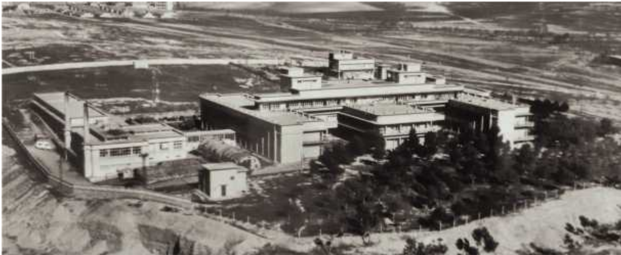
Figure 110: Hôpital civil de Sétif. Eclatement de la boîte. Source : Fonds J-H, Calsat, Université de Genève, Archives d'architecture.
