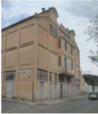
Figure 3 : Les docks de la Compagnie algérienne Vue extérieure. Arch : P.L Bonnell, Entr : P.L.Giovanelli, Sétif (Algérie), 1908, (BAH) Source : Photo de l'auteur (2012)
