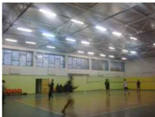
Figure 12 : La Salle de sport avec les poutres triangulées Source : Photos de l'auteur, 2014.
