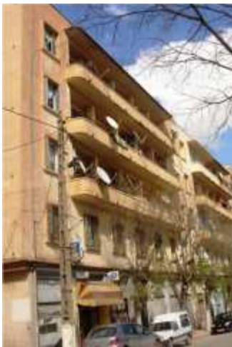
Figure 101: L'immeuble Brincat 1 (La Pinède), Source : Photos de l'auteur (2009)
