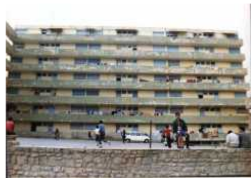
Figure 47: La cité du palmier, vue extérieure. Une architecture des plus austères offrant quand même des espaces de sociabilité (Coursives, esplanade à différents niveau, escaliers, etc.).
