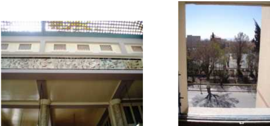
Figure 66: L'hôtel des finances, détails d'intérieur : A gauche, porte-à-faux, éclairage zénithal et fresque rupestre. A droite, Fenêtre disposée au bout d'un couloir offrant une vue panoramique sur le jardin des sports. Source : Photo de l'auteure 2009.
