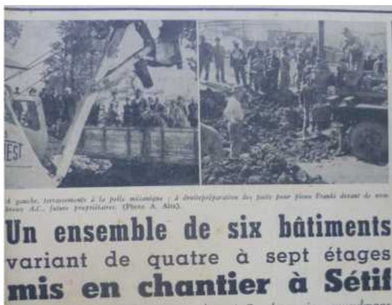
Figure 21 : La cité du palmier, Sétif, Préparation des pieux Franki. Source : Journal Général, Travaux Publics et Bâtiments, 19 avril 1957
