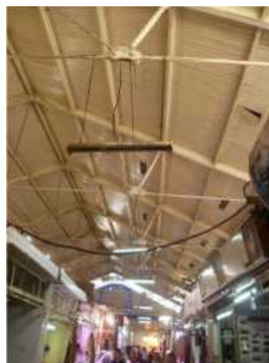
Figure 11 : La halle de Sétif, vue intérieure. Les fermes utilisées Correspondent aux poutres Polonceau. (A treillis et tirants articulés) Source : Photo de l'auteur, 2014.
