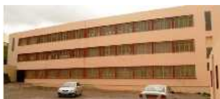
Figure 87 : L'école Amira, les façades.
