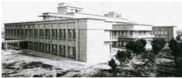
Hôpital de Sétif (X.Salvador, 1935 Source: Chantiers, février, 1938,
