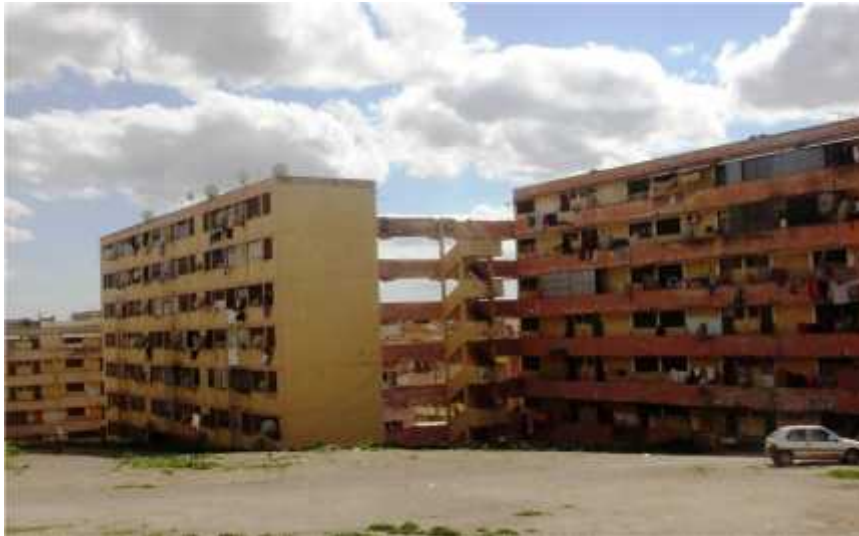
Figure 45: Diar Enakhla, coursives, passerelles et escaliers extérieurs (2008).
