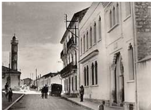
Figure 104: Ecole El Feth, au fond la mosquée de la gare Source : https://www.google.dz/ecole-el-feth
