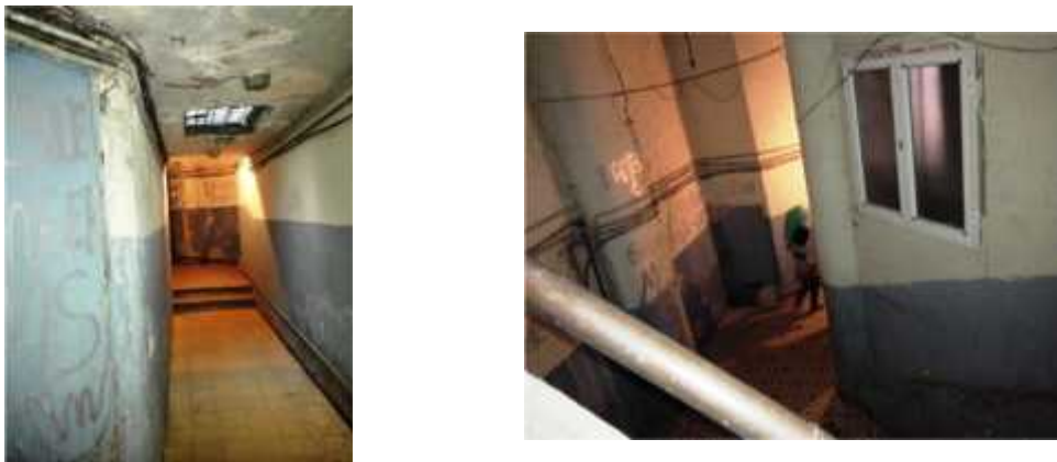
Figure 59 : Entrée de l'immeuble Brincat3. A gauche, le passage sous la maison mitoyenne. A droite une vue à partir de l'escalier. Source : Photo de l'auteur (2014).
