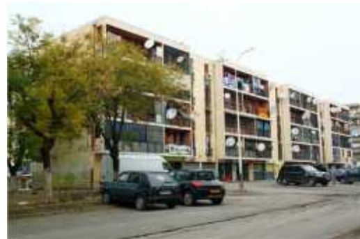
Figure 91 : L'une des quatre barres parallèles (Ph. 2014) Source : Photo de l'auteur (2014)
