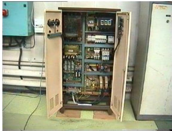
Figure 4.19: Armoire de commande du Moteur
