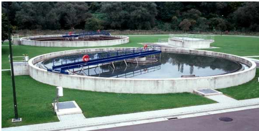
Figure 2.5 : Décanteurs d'une station d'épuration
