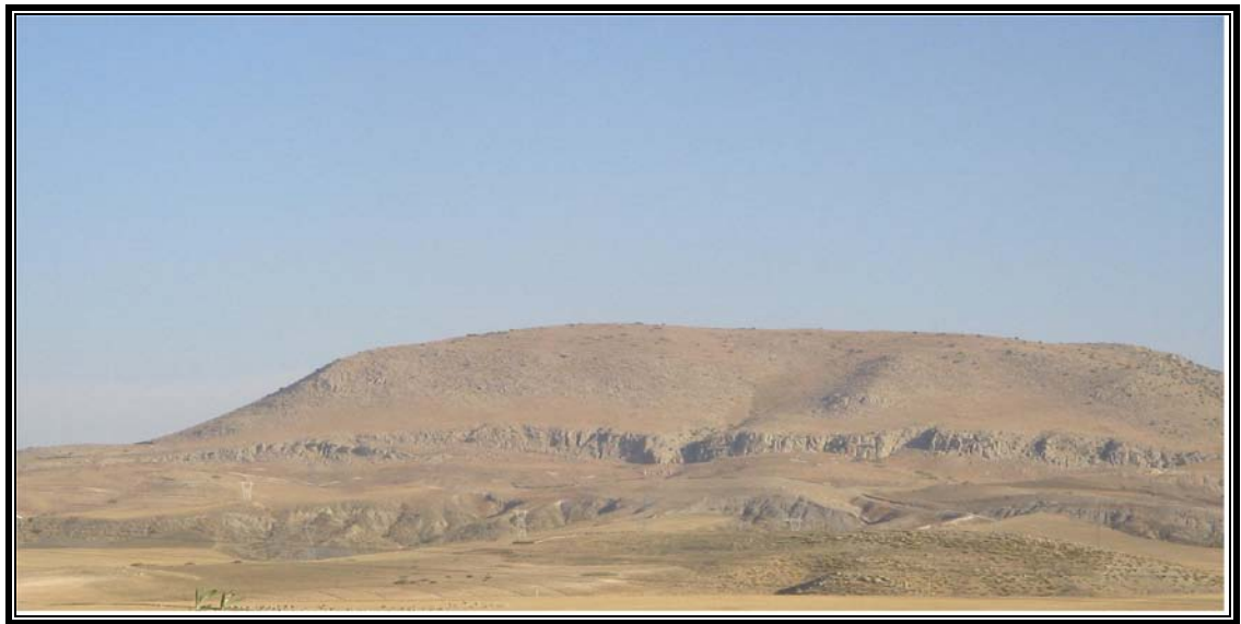
Fig II.8: l'escarpement de faille de Dj.Feltene.
