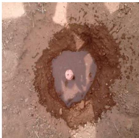
**Fig.2.8** Ajout de l'eau de la mer morte au trou du système de mise à la terre [34].
