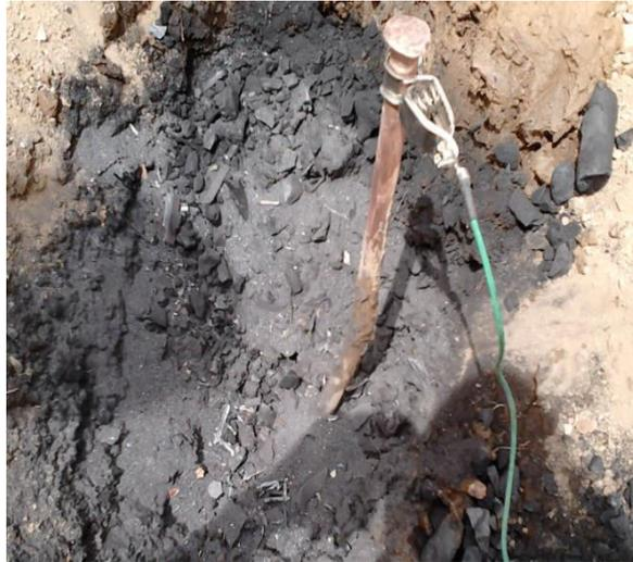
**Fig.2.9** Ajout de l'eau de la Mer Morte avec du charbon et de la limaille de fer dans le trou du système de mise à la terre [34].
