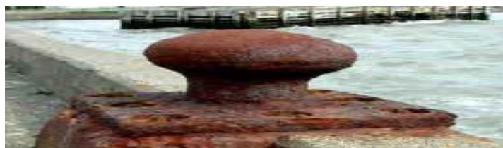
Figure I.6 : Exemple de corrosion uniforme
