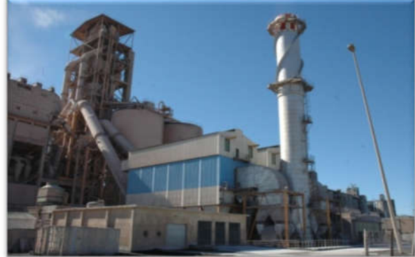
APRES « filtres à manches » [C] < 10 mg/Nm 3
